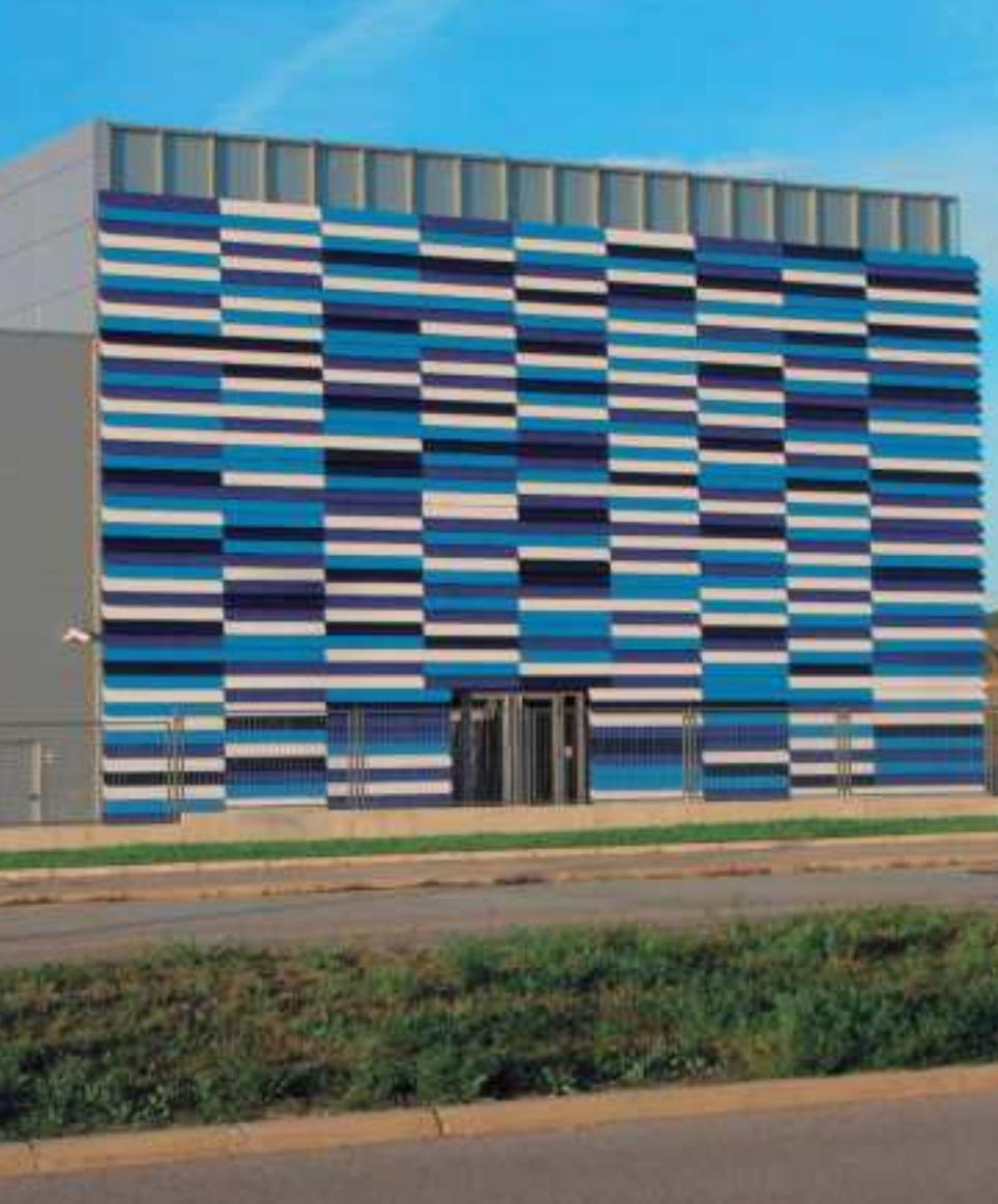
La fachada es un elemento de referencia del edificio y a su vez, un sistema de control solar.
