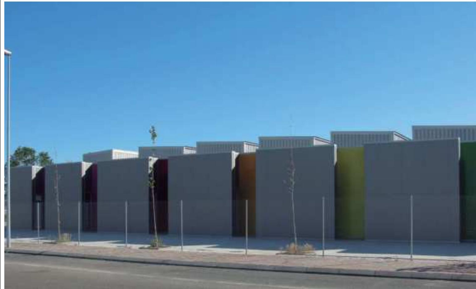
Visualmente destaca la solución constructiva de cerramiento de U-glass, que tras de sí transparenta fragmentos de las letras de la marca de la empresa de una manera descolocada, pero fácilmente reconocible.
